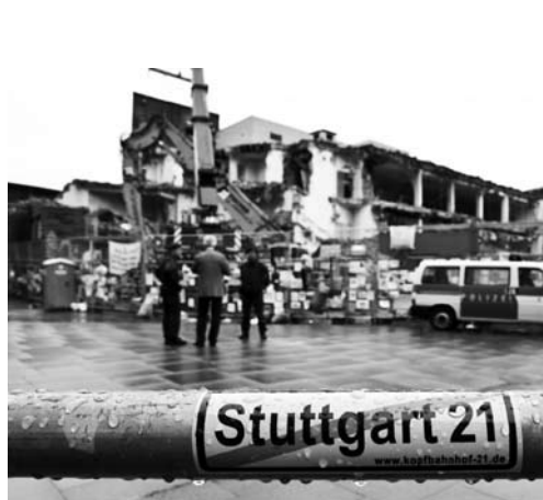
Строительная площадка будущего вокзала. Фотограф Дженс Зендер. Фото с сайта http://www.david-schmitz.net .
