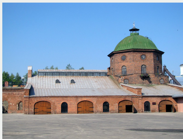
Рис. 8. Полевской. Северский трубный завод, музей «Северская домна».
