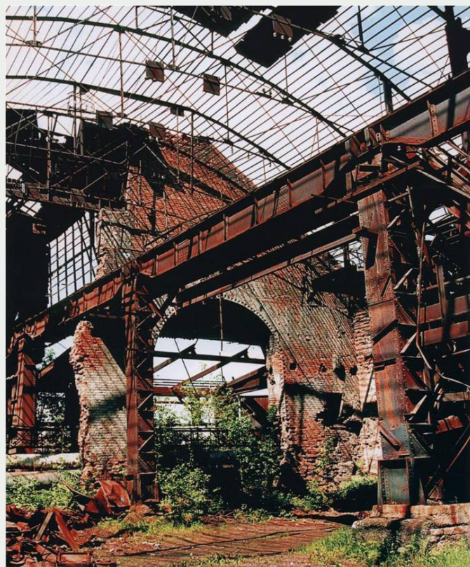
Рис. 13. Нижнетагильский музей-завод: внутренний вид мартеновского цеха (1890-е годы).
