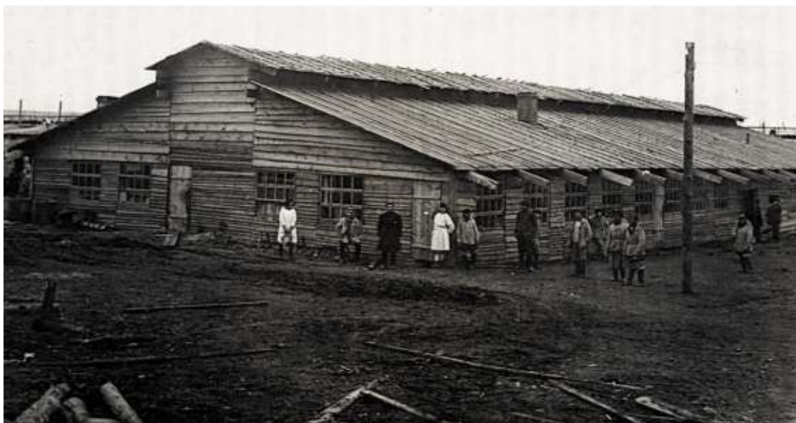
Илл.37. Столовая на строительстве плотины № 1 в соцгороде Магнитогорске. Источник: предоставлено В.А. Токаревым
