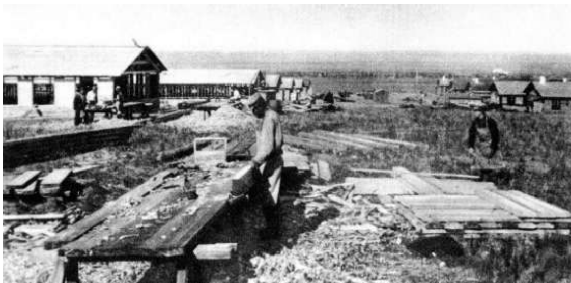
Илл.27. Строительство бараков в Магнитогорске к зиме 1929 г. (фотография датирована 30 августа 1929 г.). Источник: Предоставлено В.А.Токаревым
