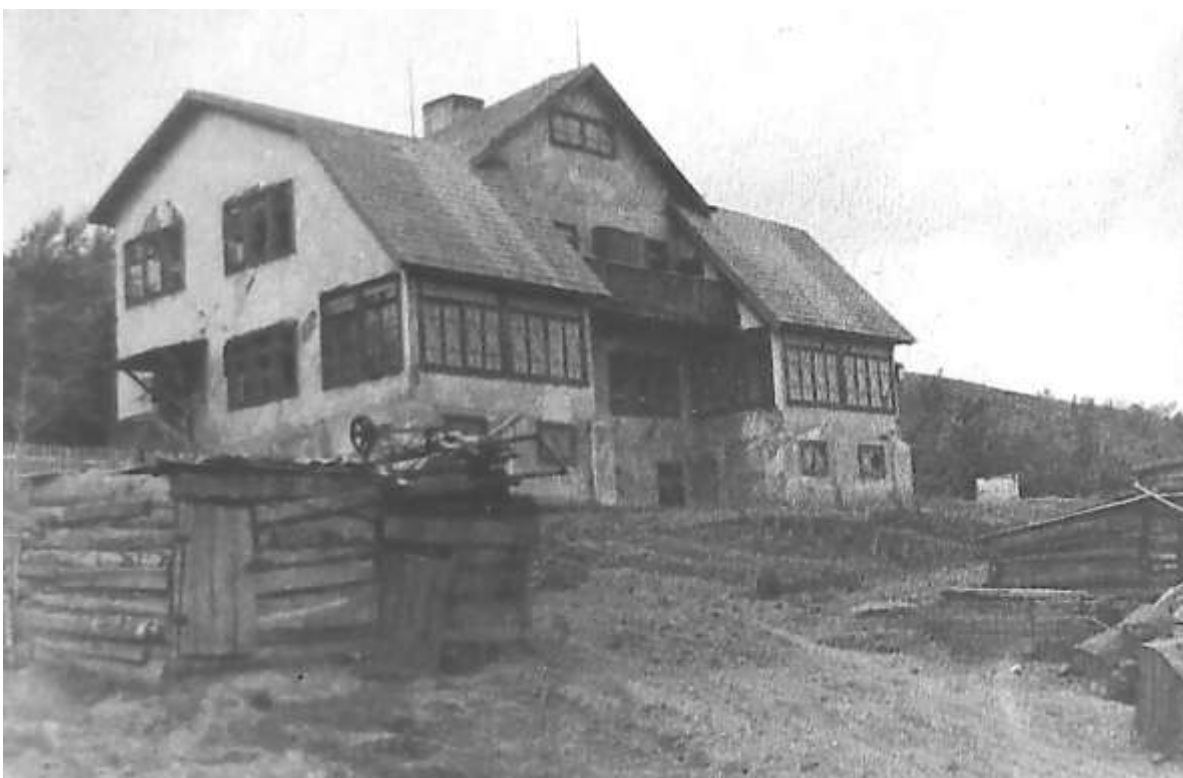
Илл. 17. Кузнецкстрой. Верхняя колония. Коттедж (2-х квартирный каркасно-засыпной).
