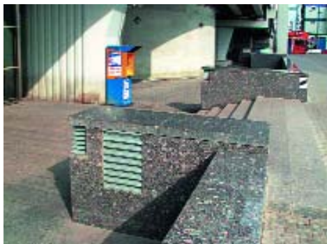
Вход на станцию метро «Международная». Вентрешетки вмонтированы в гранитные парапеты.
