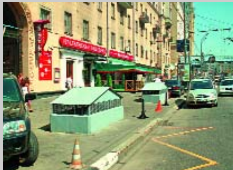
Садовое кольцо. Вентобъект, окрашенный в защитный цвет, выполнен по временной схеме, но стоит тут уже несколько лет.
