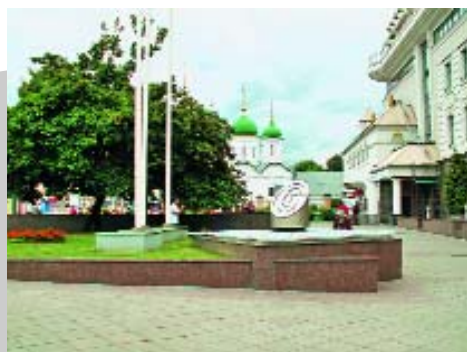
Вентобъект рядом с метро «Сухаревская». Сооружение сопровождения подземных сетей вписано в ландшафтную композицию пешеходной площади.
