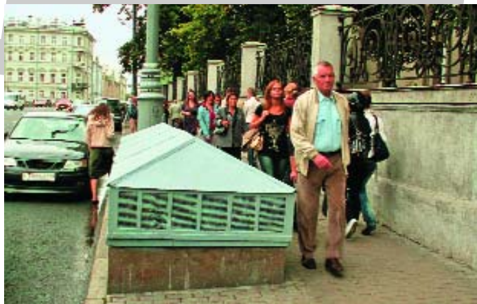
Вентвытяжка на улице Моховая рядом со старым зданием МГУ препятствует нормальному движению пешеходов.
