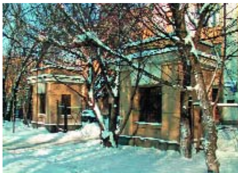
Биопочвенный корпус МГУ на Воробьевых горах. Вентобъекты расположены по центру ландшафтной композиции внутреннего двора в обрамлении неисторических фасадов.
