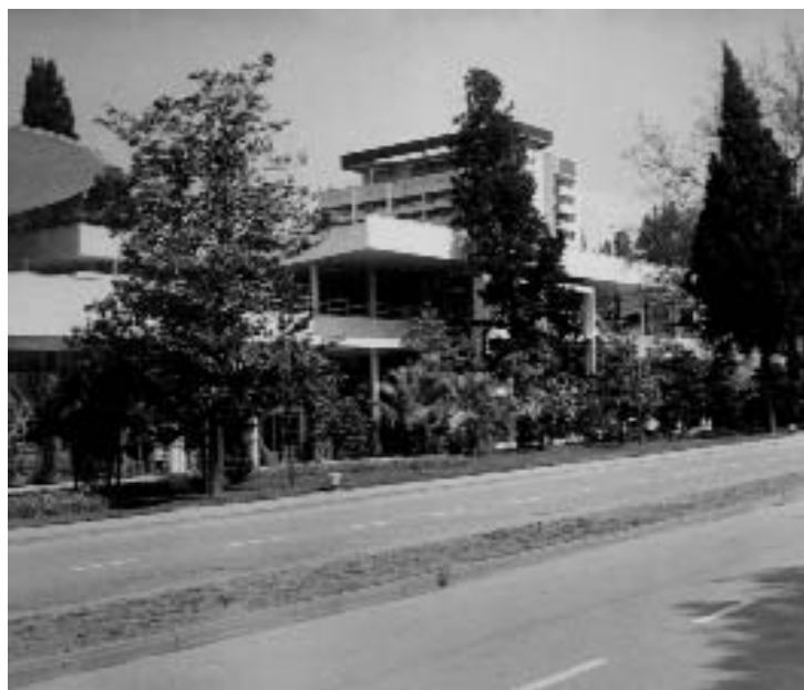
Вид на галерею со стороны Навагинской улицы. Второй блок.
