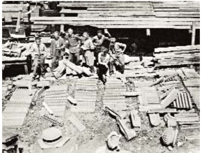
А.Мндоянц с мастерами на постройке Корабельной конторы в Батуме. 1933 г.
