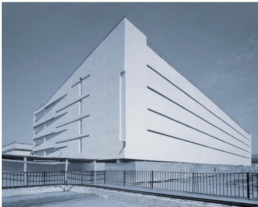
Гараж-паркинг на ул.9-я парковая.
