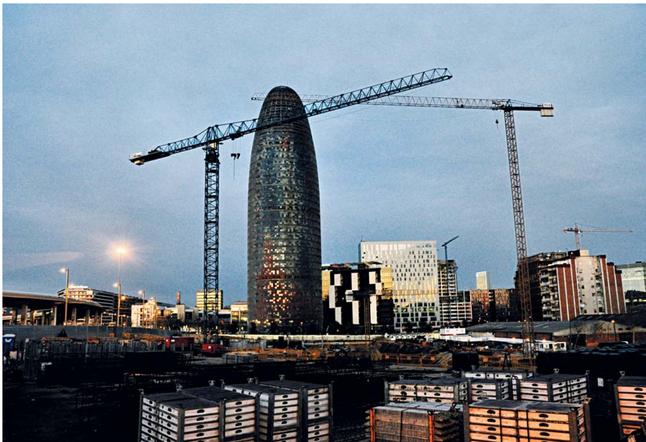
Башня Акбар в окружении строительных лесов, которые добавляют еще больше «чужеродности» к ее облику.
