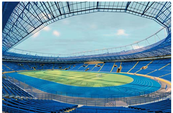
Реконструкция Областного спортивного комплекса «Металлист» в Харькове.
