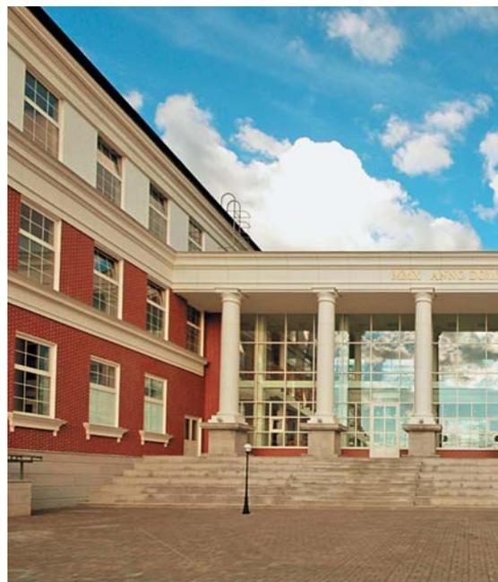
**М.Б.** Современная технология производства высокопрочного тонкостенного стеклофибробетона позволяет выполнять любые по сложности архитектурные детали. Так, вопреки модернистской логике, классическая, академическая форма снова становится инновационной, хоть на дворе и XXI век.
