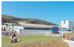
Завод компании Trimo в Требье близ Любляны.
