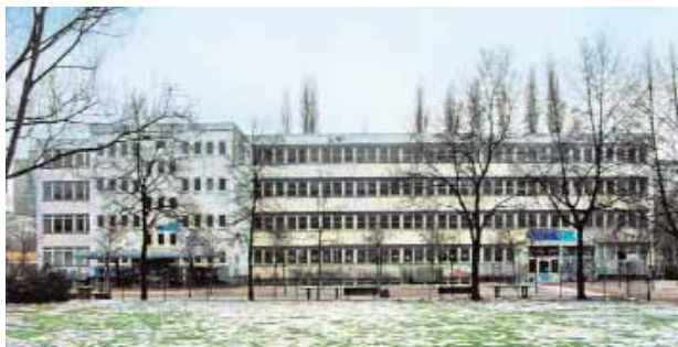
Состояние школы им. Бернарда Розе, серия «SK-Berlin», перед реконструкцией. Condition of the school named after Bernard Rose, "SK-Berlin" series, before reconstruction.
