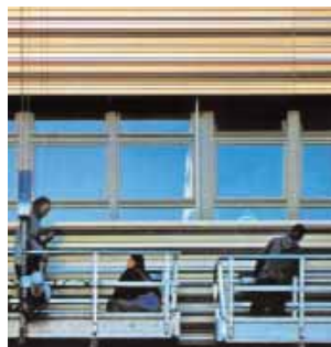
Школа им. Бернарда Розе. Монтаж новых фасадных элементов в процессе реконструкции. Installation of the new facade elements during the reconstruction.
