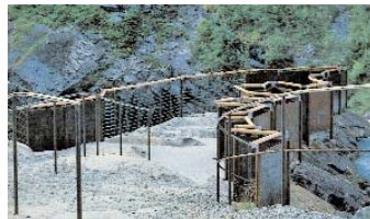
Видовая площадка на водоеме Висдестер. Архит. Йенсен & Сюдвин.
