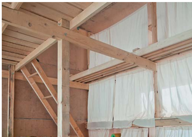
Проект собран по каркасной технологии. В качестве облицовки использованы «сэндвич»-панели из оргалита, утеплителя и крашеной фанеры, а светопропускающие фасады выполнены из сотового поликарбоната толщиной 25 мм.
