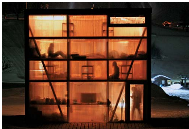
Проект собран по каркасной технологии. В качестве облицовки использованы «сэндвич»-панели из оргалита, утеплителя и крашеной фанеры, а светопропускающие фасады выполнены из сотового поликарбоната толщиной 25 мм.
