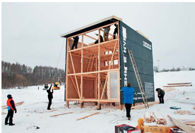
Проект собран по каркасной технологии. В качестве облицовки использованы «сэндвич»-панели из оргалита, утеплителя и крашеной фанеры, а светопропускающие фасады выполнены из сотового поликарбоната толщиной 25 мм.
