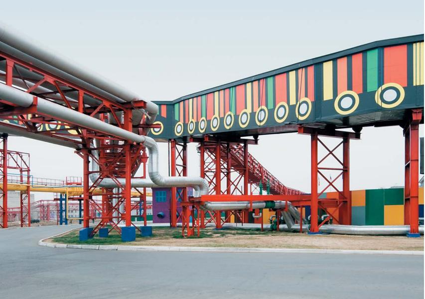
В экстерьере красным цветом обозначены металлические опорные конструкции, а синим – бетонные. Red in the exterior defines metallic support structures and blue mark concrete structures.
