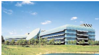
Исследовательский корпус компании Lucant Technologies, Нэпerville, Иллинойс, США, 2001 г. Экстерьер со стороны входного павильона. Интерьер входного павильона. © Kevin Roche John Dinkeloo and Associates.
