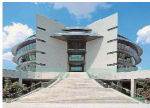
Кампус штаб-квартиры банка Santander, Мадрид, Испания, 2005 г. © Kevin Roche John Dinkeloo and Associates.
