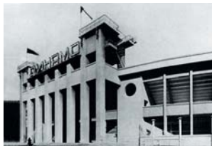
Входной портал кожного входа на стадион «Динамо». Фото 1937 года. Памятник федерального значения. В процессе реконструкции сохраняется.
