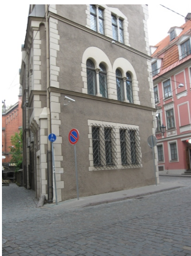
«Венецианские окна» второго этажа здания
